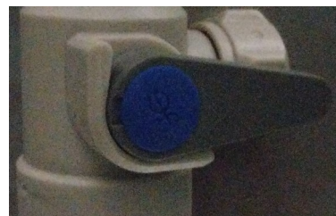
Double check valve (anti syphon)
